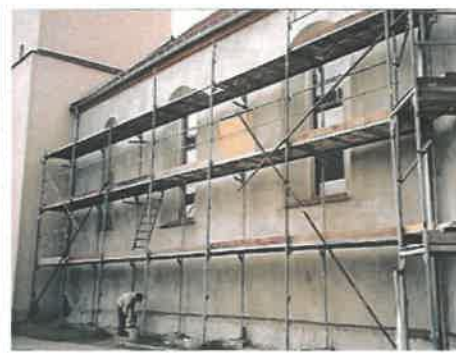
Remont elewacji – ok. 2000r.
