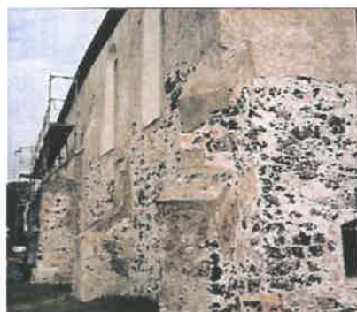
Remont elewacji – ok. 2000r.
