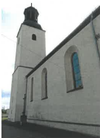
Stan obecny elewacji
