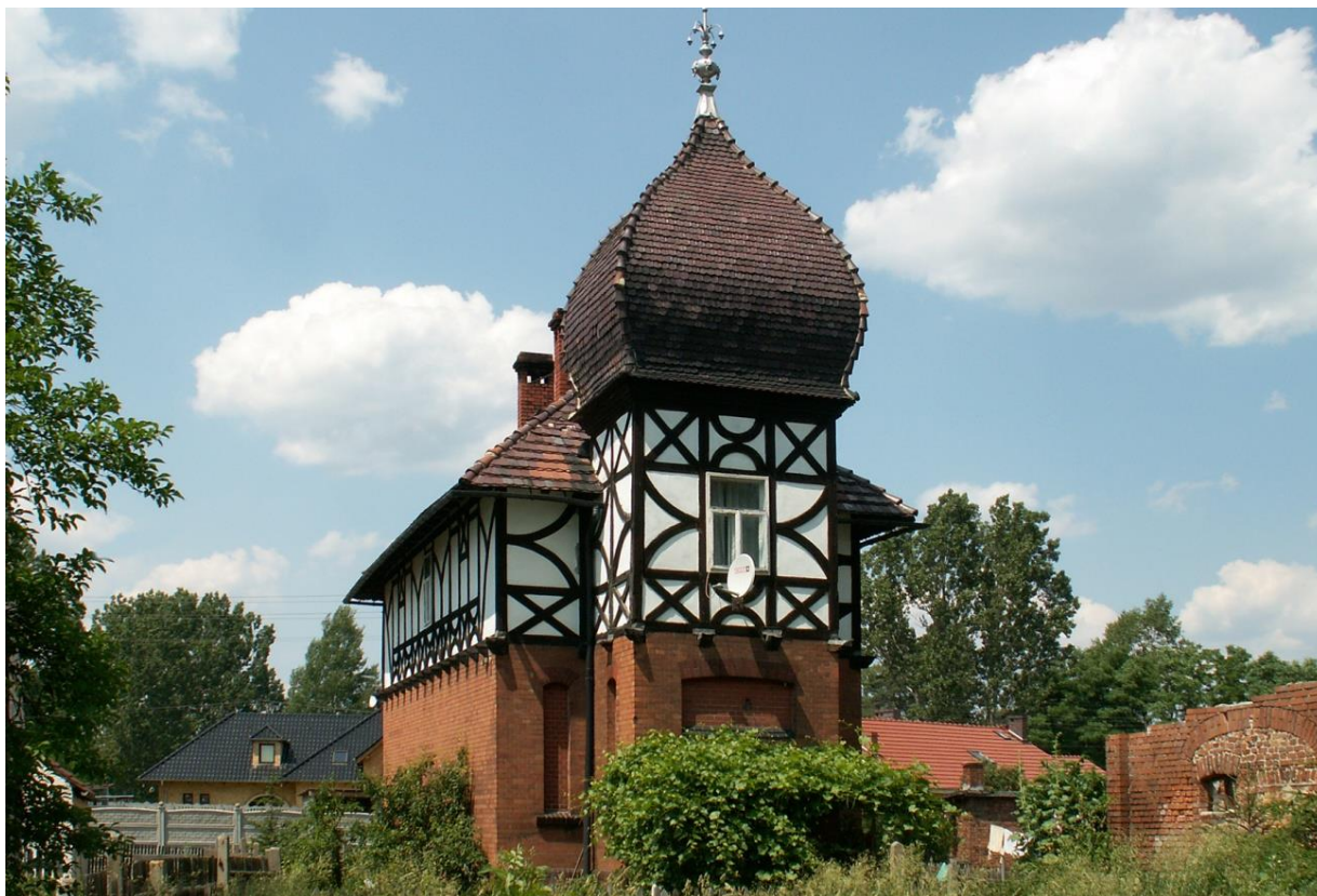
Dom z fragmentami muru pruskiego.
