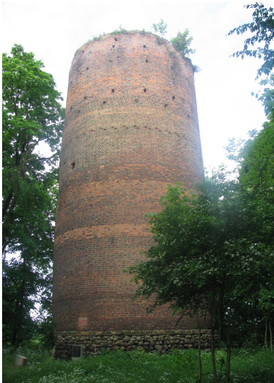
Wieża głódowa w Przewozie
