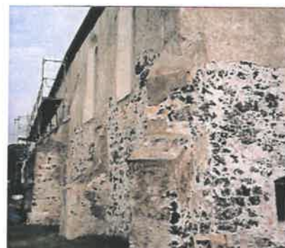
Remont elewacji – ok. 2000r.
