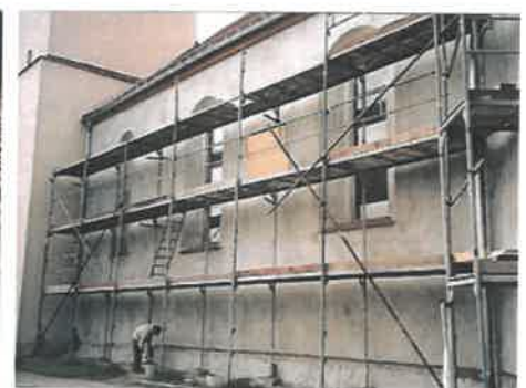
Remont elewacji – ok. 2000r.
